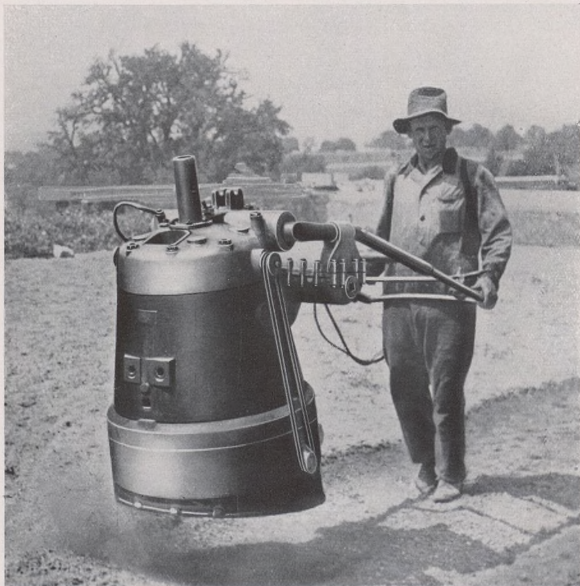
Apisonadora de alta potencia, que se construye hasta de 2000 kgs. de peso
