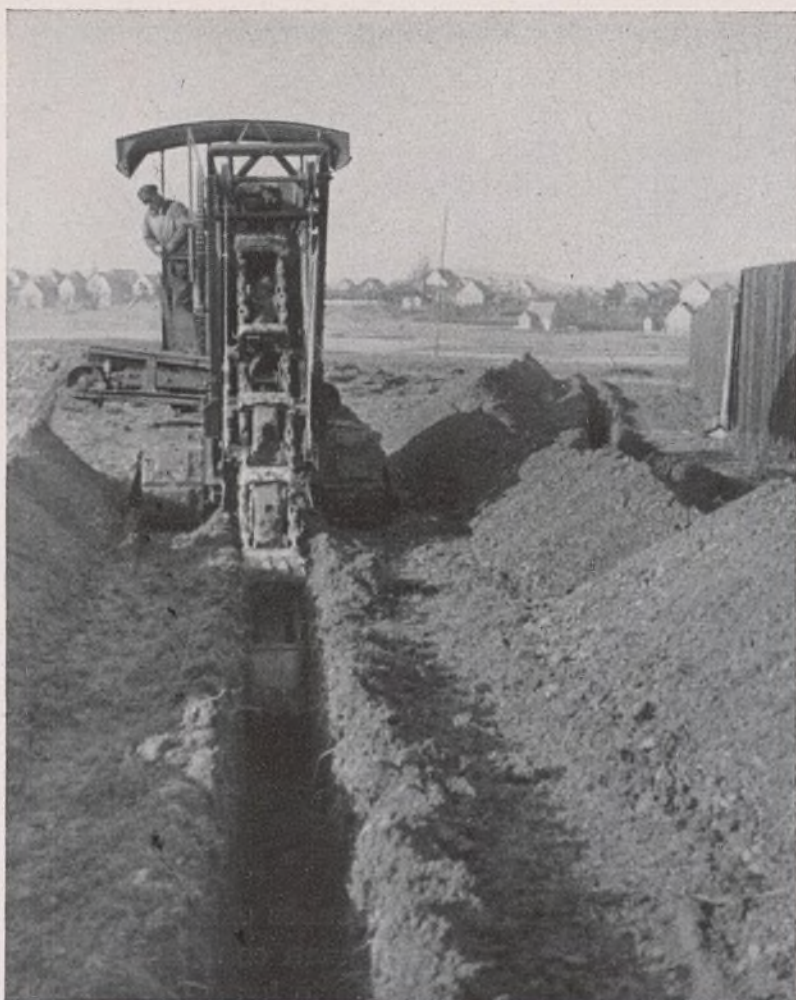
Fig. 7: Excavadora para abrir zanjás y colocar tubos, cables etc. transportador lateral. Éste lleva la tierra directamente al sitio junto a la zanja donde ha sido excavada, de manera que hace innecesario el transporte de la tierra cuando hay que volver a llenar la zanja.
