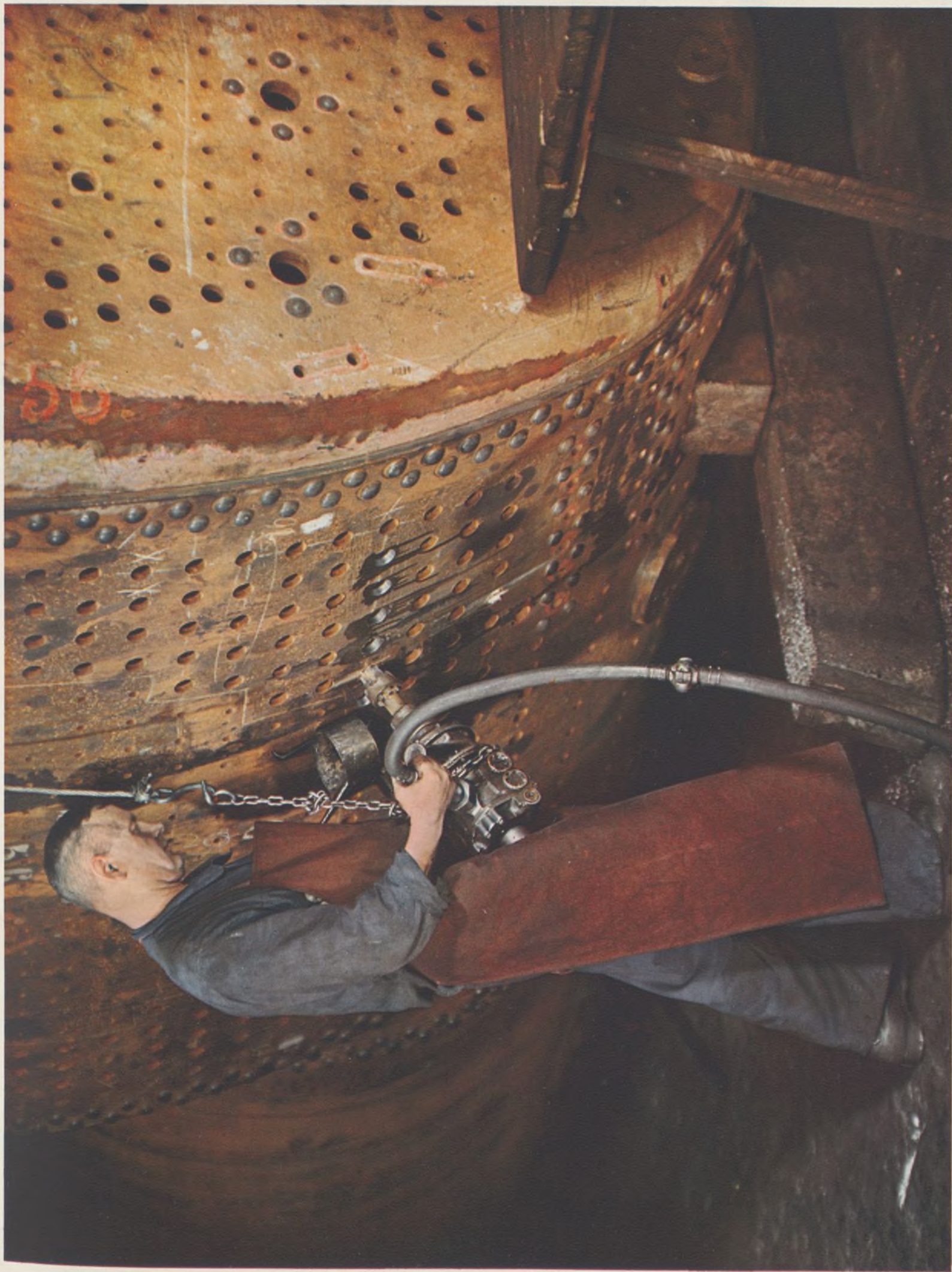
AUFREIBEN DER STEHBOLZENLÖCHER AM LOKOMOTIV-STEHKESSEL
