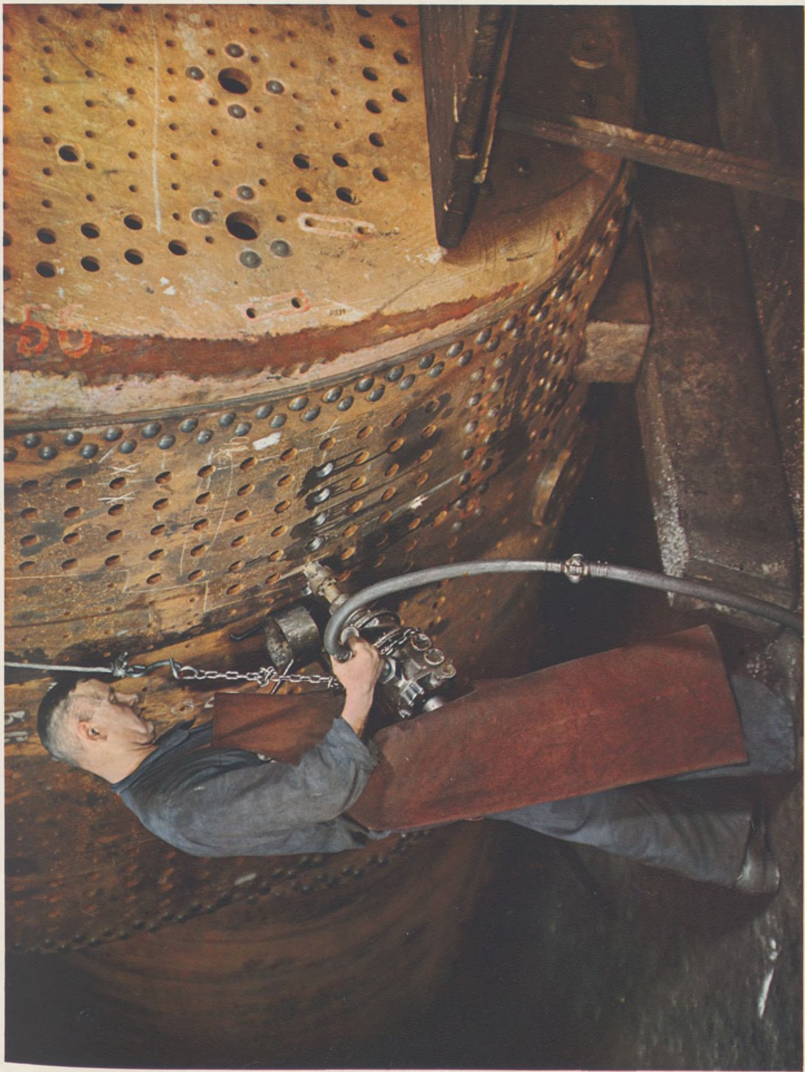
AUFREIBEN DER STEHBOLZENLÖCHER AM LOKOMOTIV-STEHKESSEL
