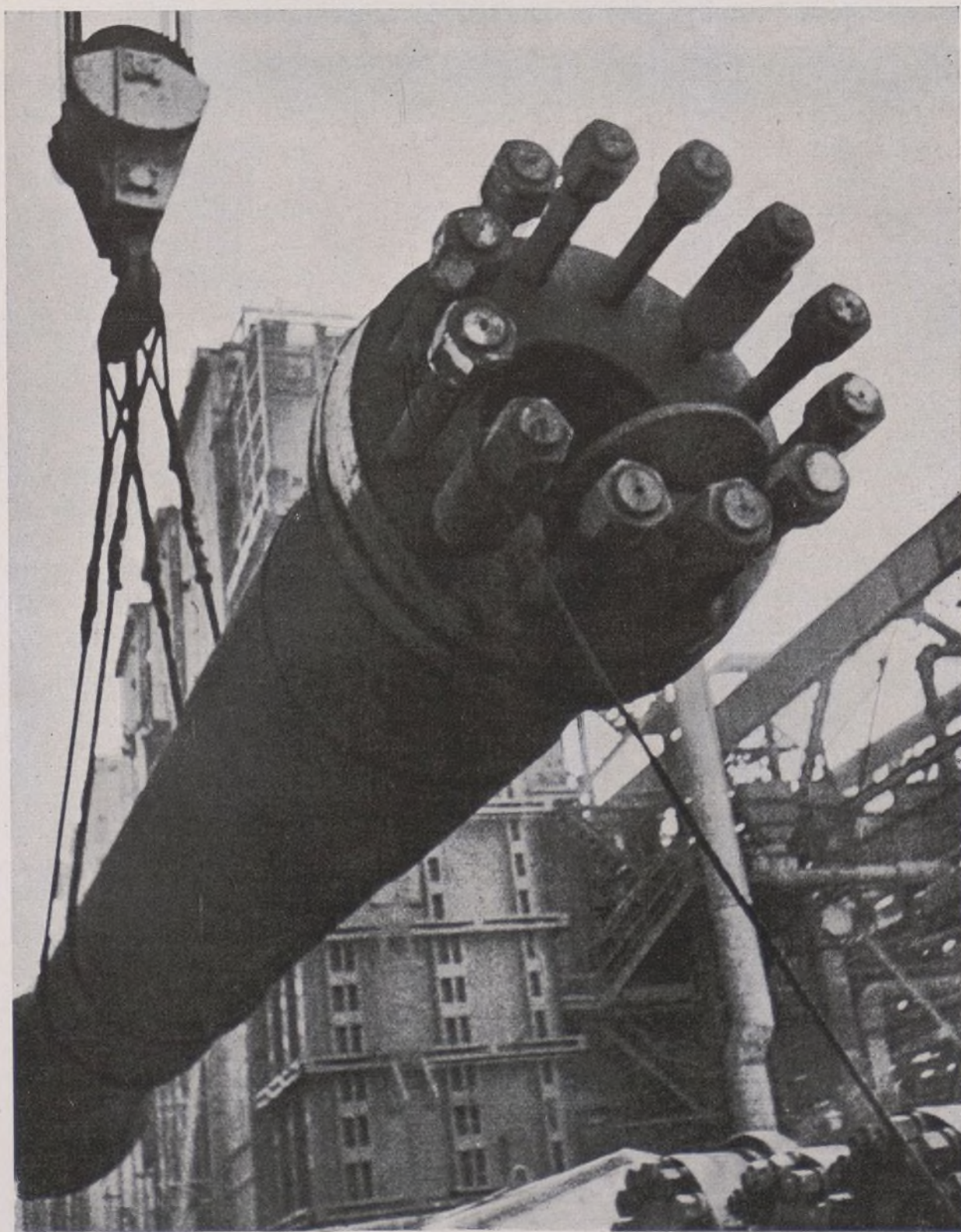
Caldera de alta presión para una fábrica de bencina sintética
