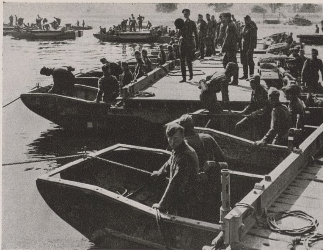
Detalle que muestra la precisión matemática con que se ensamblan los diferentes tramos de un puente de pontones construido por zapadores alemanes
