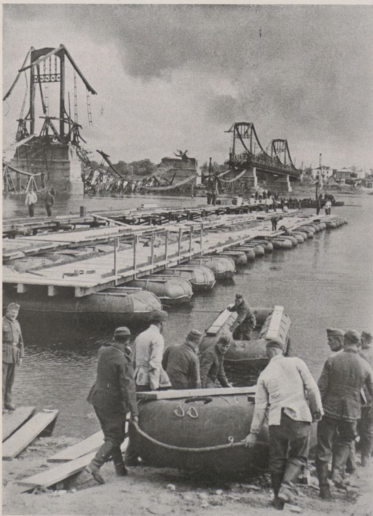
Dentro de 24 horas los zapadores alemanes construyeron varios puentes sobre el Dniéper cerca de Kiev, capital de la Ucrania, en reemplazo de los volados por los soviets
