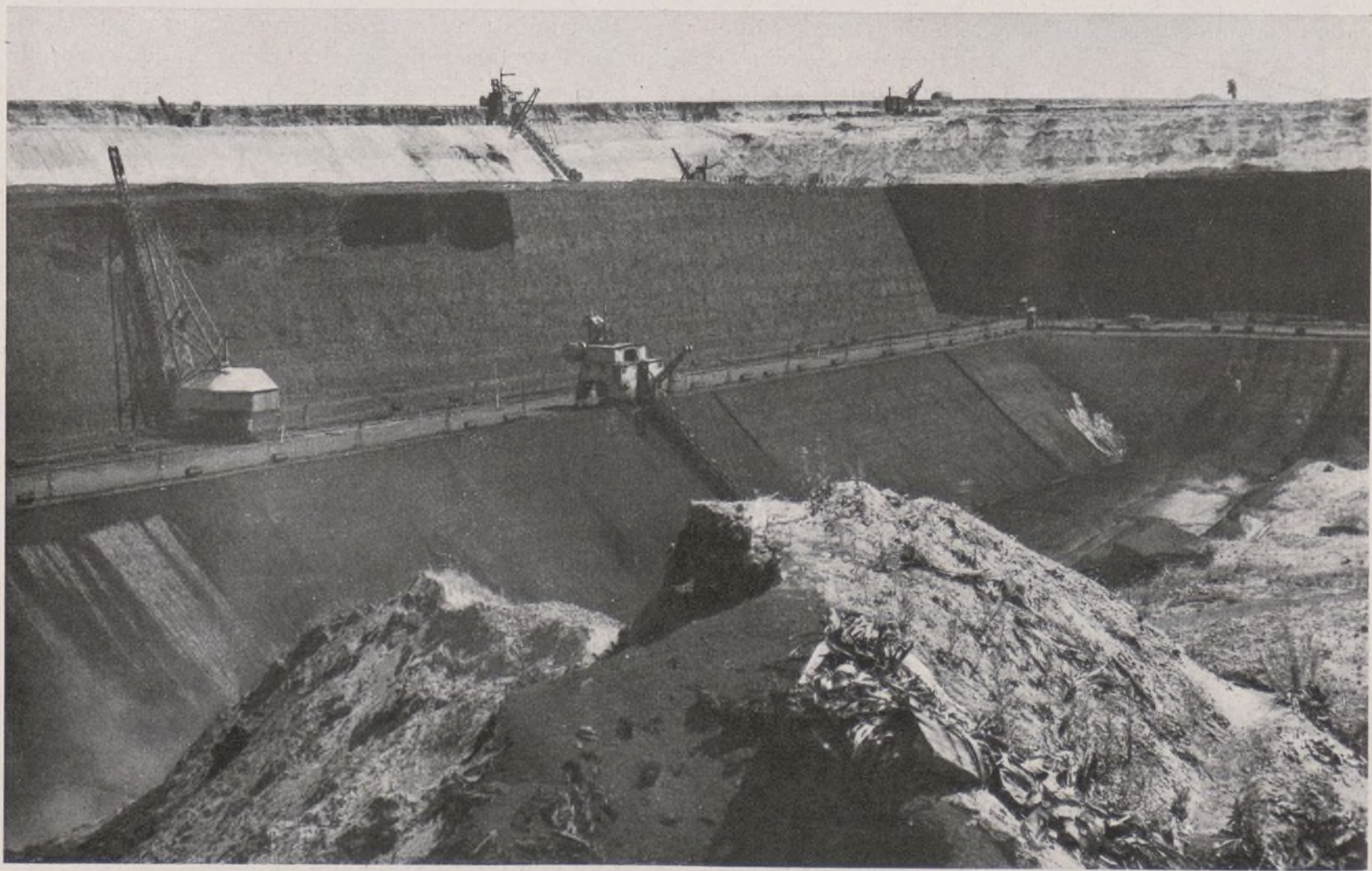
Explotación al raso de grava, arcilla y carbón en la mina de Türrich. Dos dragas de cuchara sacan en el escalón superior el escombro de grava y una draga de fondo, en el escalón inferior de descombrar, la arcilla. Estas tres dragas descargan en el plano común donde corre la vía de descombrar. En el estrato de carbón superior trabaja una draga rascadora y en el inferior, una draga de fondo; ambas descargan en el plano común de la vía de transporte del carbón
