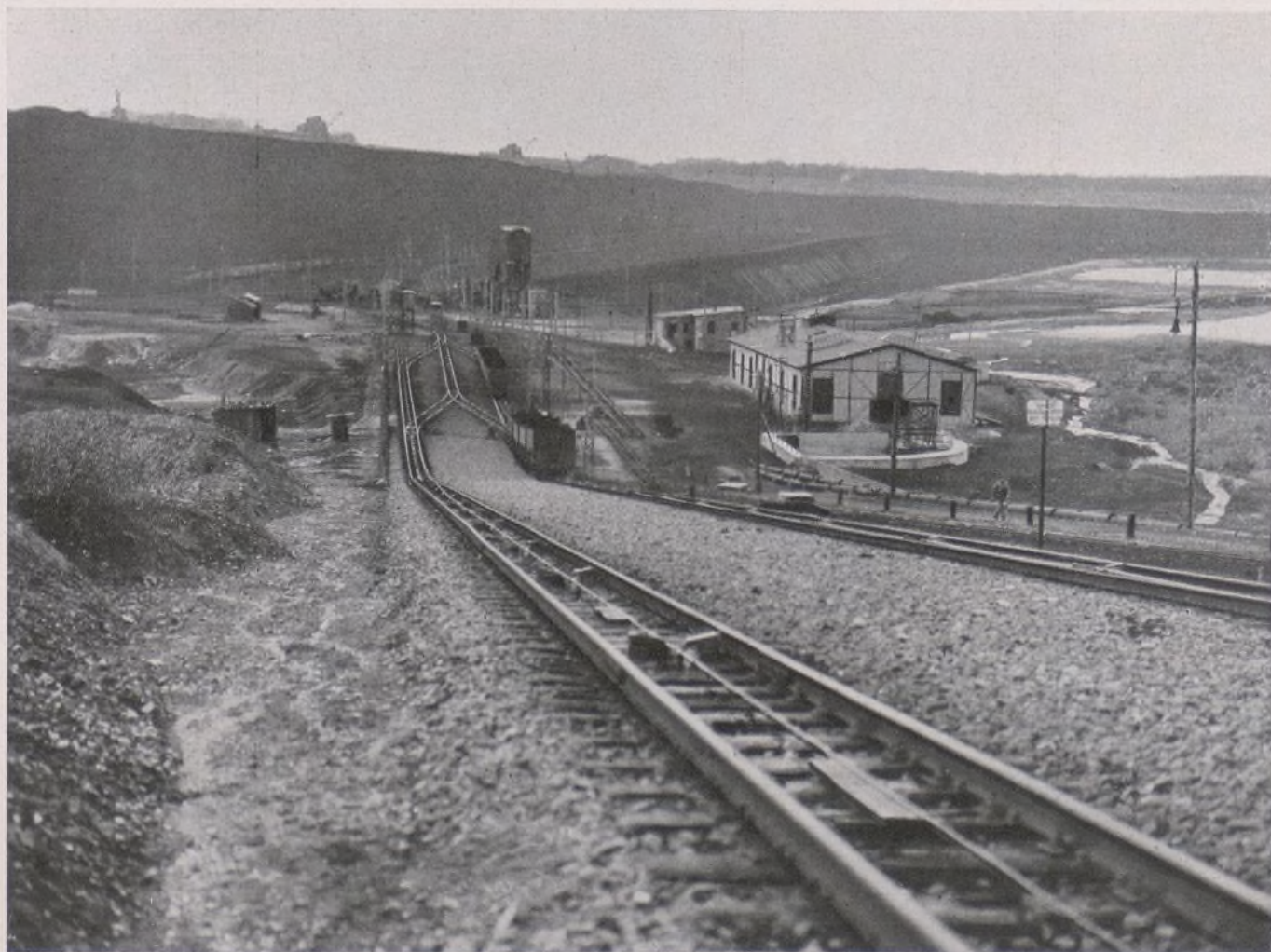
Ascensor por plano inclinado. Vista desde el plano inclinado a la estación baja en una mina de lignito de explotación al raso. La foto muestra el cambio de trenes. El tren cargado ya se encuentra en la vía de transporte en el plano bajo entre los dos cambios de vía
