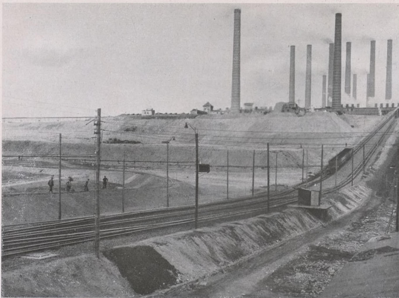
Ascensor por plano inclinado. Vista del plano inclinado desde abajo. Ascenso de 1:6; altura de elevación: 56 m. Rendimiento: 12 000 toneladas de lignito en bruto en 20 horas. El ascensor lleva los trenes hasta el depósito alto instalado encima de la separación de la fábrica de briquetas
