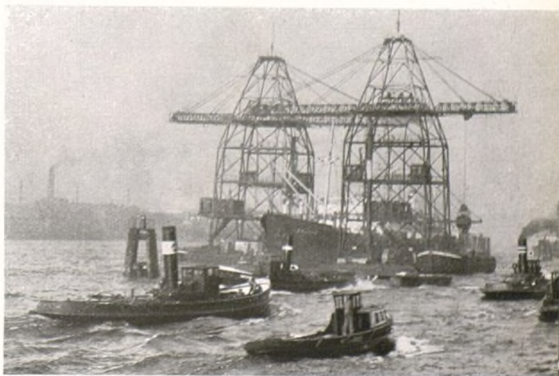
Descargar de minerales por medio de grúas de cuchara flotantes
