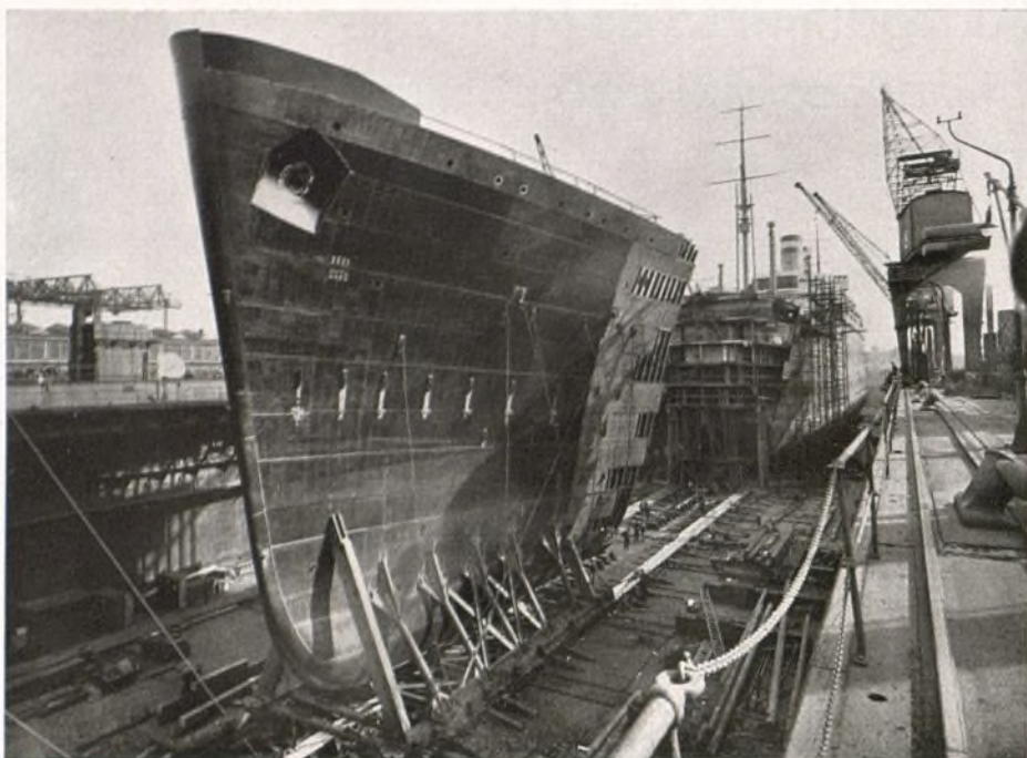
Tirando lentamente, con ayuda de aparejos, sobre el deslizadero del dique, la proa nueva hacia el vapor
