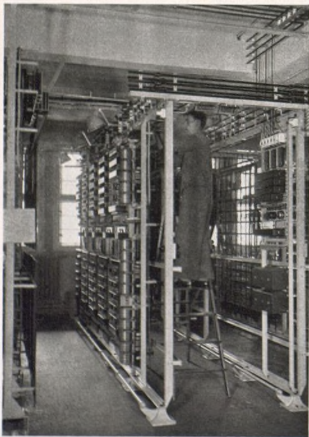
Grab. 3: Selector y relevador automático que, accionado por el abonado al servicio de teletipografía, establece la comunicación
