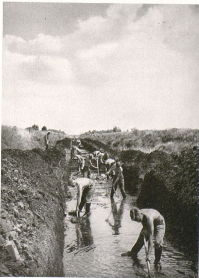
Un contingente de 250 000 muchachos tendrá trabajo por espacio de 40 años para cultivar 8 000 000 de hectáreas de tierra inservible hasta ahora — Los muchachos construyendo un canal de desagüe a través del gran pantano del distrito de Oldenburgo
