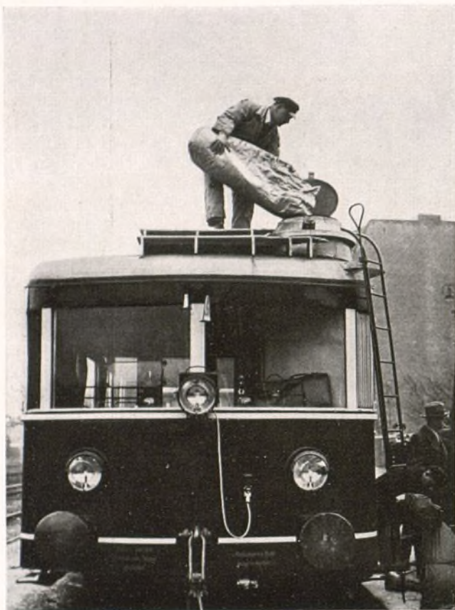
El primer coche-motor a gas de antracita que en un generador de gas produce su propio combustible
