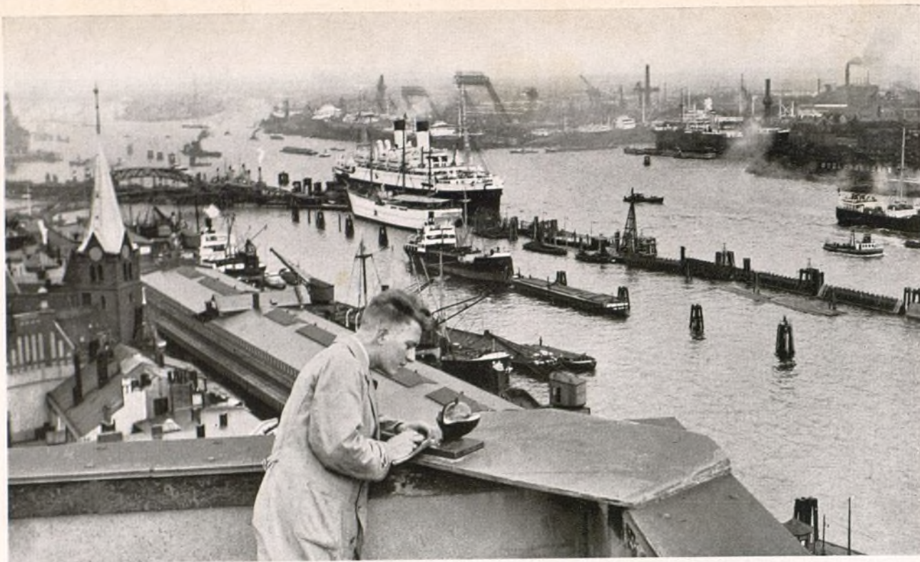
Vista desde el techo del Observatorio Náutico Alemán al puerto de Hamburgo. Nuestra foto muestra el helioscopio instalado en el techo. Cuando el sol alumbra, quema a través de la bola de vidrio agujeros en una tira de papel, provista de una división cronológico y fechas, de suerte que es posible establecer con exactitud cuándo y cuánto tiempo ha hecho sol
