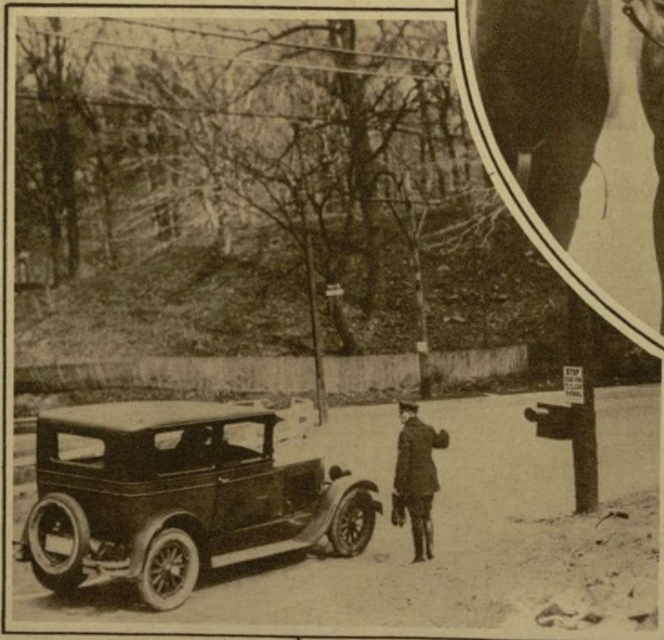
EL APARATO de señales que oye, constituye la última novedad en las carreteras de Maryland. El sonido de la bocina impresiona un receptor que deja caer unas "orejas" y al hacerlo cambia la luz verde en roja.
