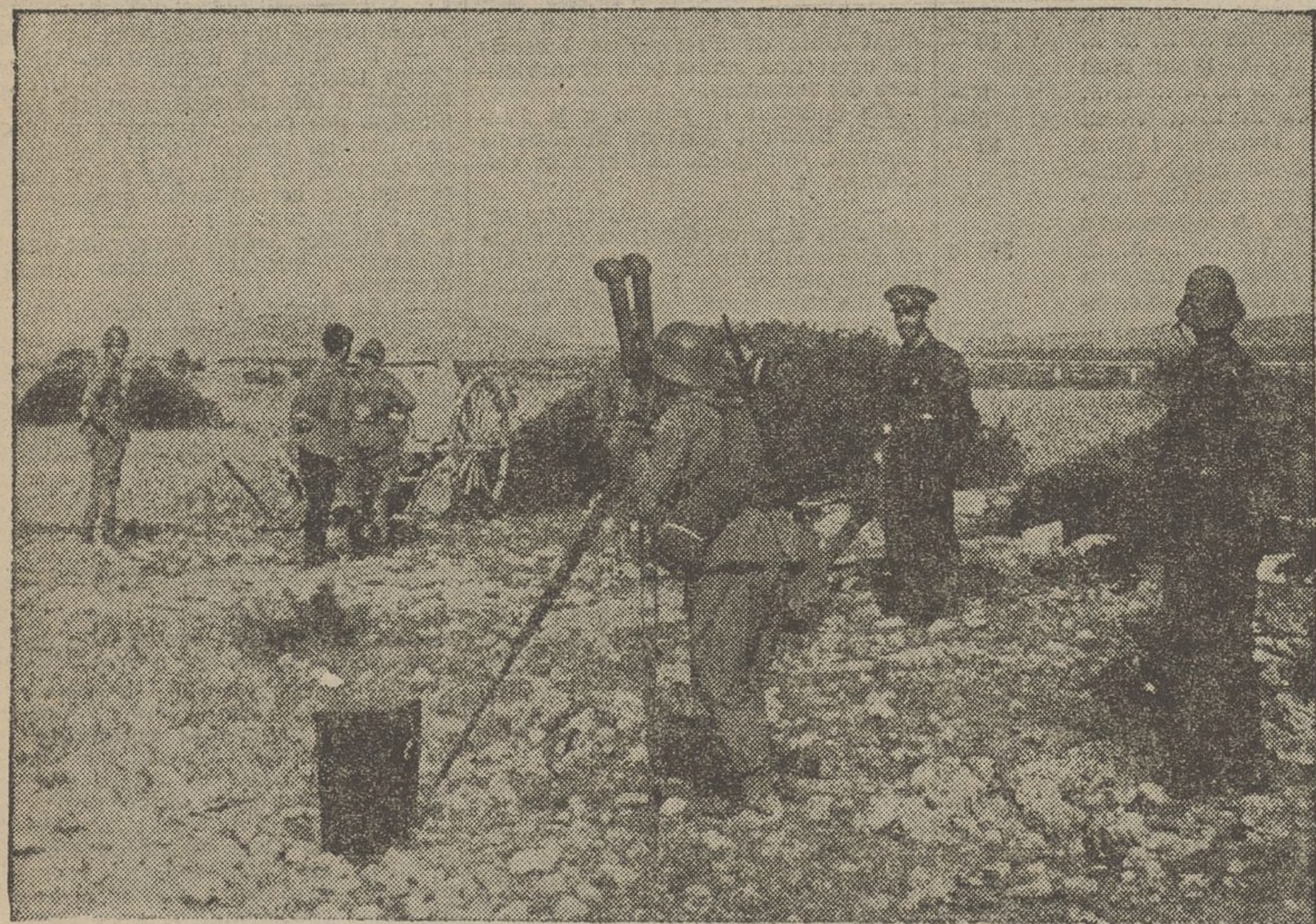
El periscopio binocular, indispensable en les operacions de l'artilleria, permet observar els efectes dels disparos del canó i rectificar la punteria. L'observador guaita amb avidesa després de cada dispar, i tothom està pendent de les noves indicacions (Foto Puig Farran.)
