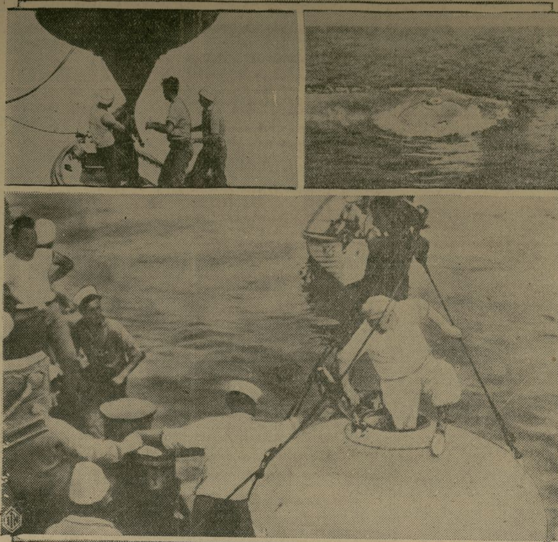
Recientemente, en aguas de Key West, en la Florida, se hicieron pruebas del tanque para salvamento de submarinos, en las cuales intervino también el submarino S-4 de la marina de los Estados Unidos. El resultado fue satisfactorio.
