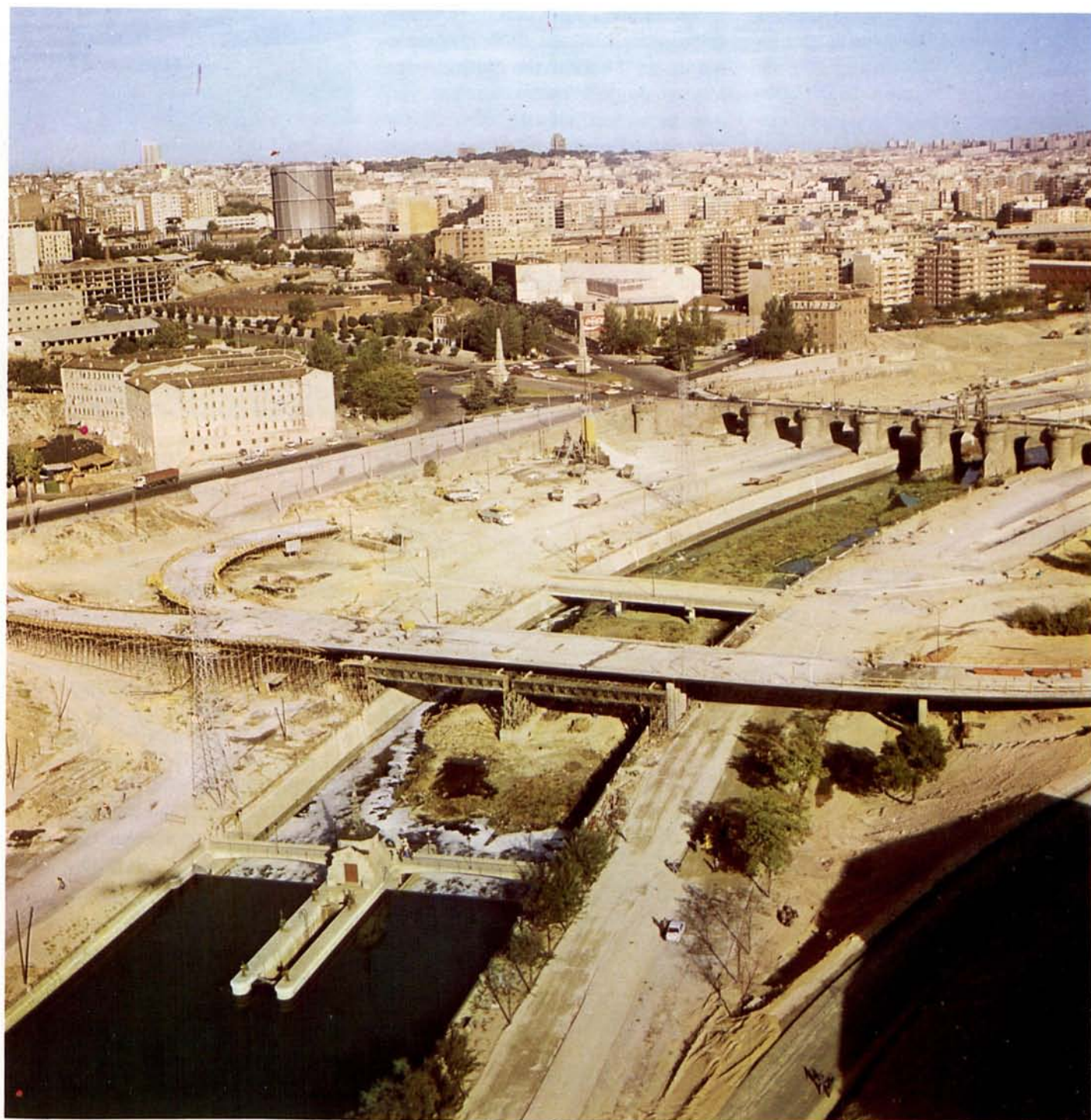
A ambos lados del puente de Toledo se elevan dos nuevos que canalizan la circulación en ambas direcciones.
