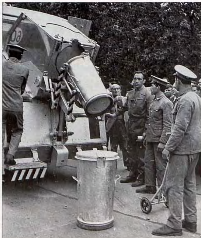
Pruebas de un camión colectivo con carga automática y cierre hermético.
