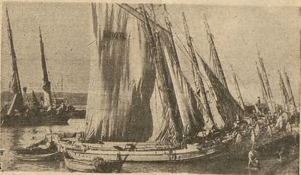
RIBERA DE PESCADORES.—Aguas arriba, esfilando con su proa la contracorriente del Tajo, barcas de pescadores portugueses vuelven de la mar. El agua dulce, que llega a Lisboa recordando riberas romancescos de Castilla y cantos de pastores de la Extremadura, va quitando de las carenas el sellero que en ellas pusieron las olas. Las velas se clavan allí donde las aguas son mitad río y mitad océano. Nadie podrá arrancarles la sombra grandiosa de guerreros y de navegantes, ni la esperanza de volver a ver unidos el timón y la espada en las nuevas empresas que decreta la voluntad de Dios.
