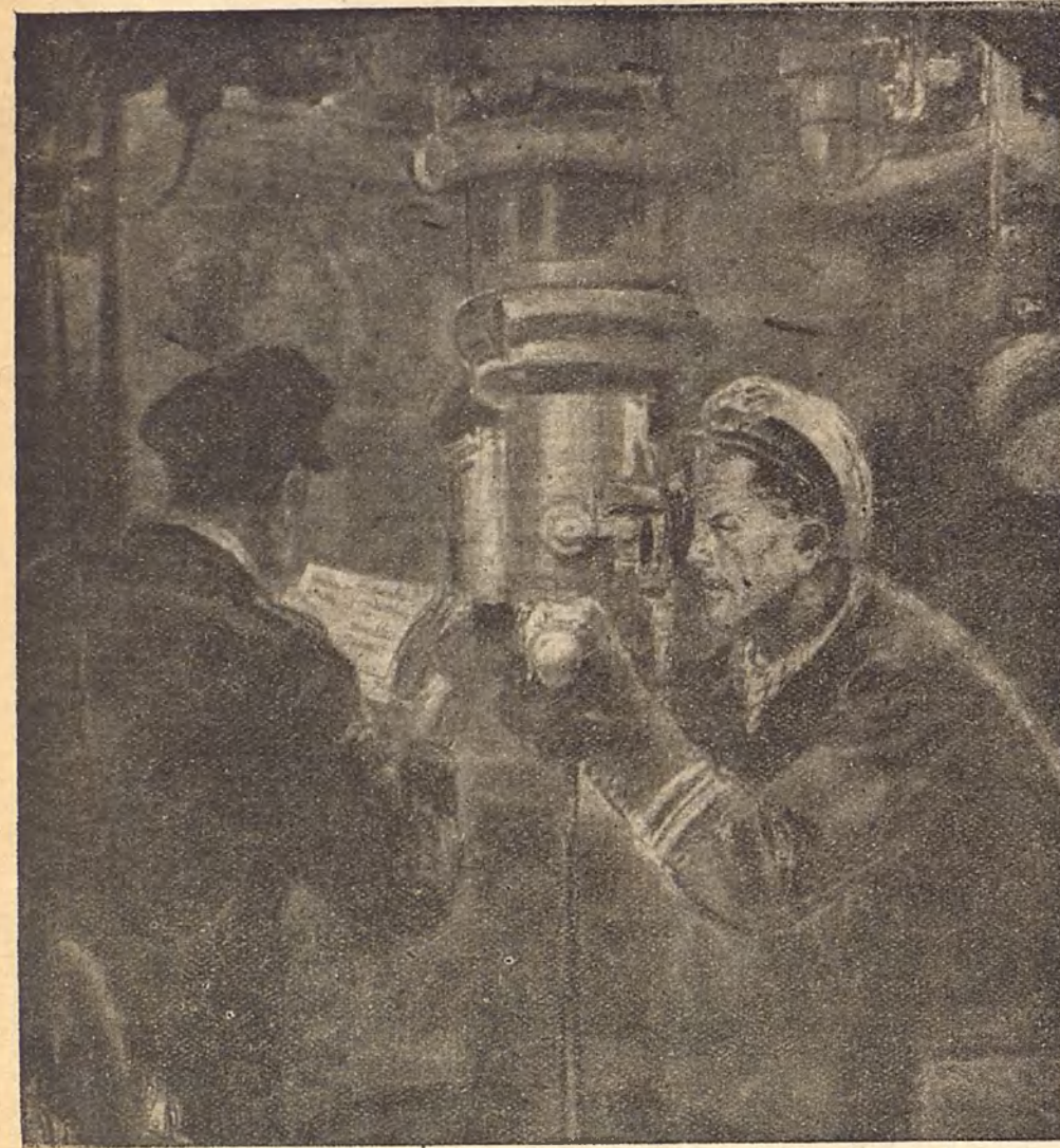
El periscopio es el único medio de visión del submarino. Manejado por el comandante sirve para regular el tiro y la posición del blanco.
