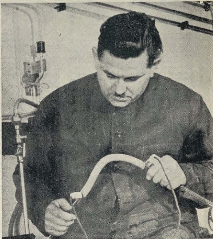
Después de preparados, un serpentín de calor eléctrico da a los tubos la forma deseada.
