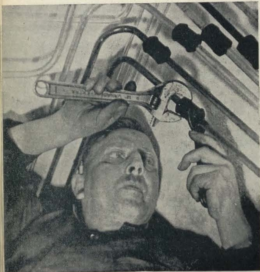
Nuevo oficio nacido en Alemania del plan cuatrienal. Permite doblar tuberías de cristal eléctricamente.
