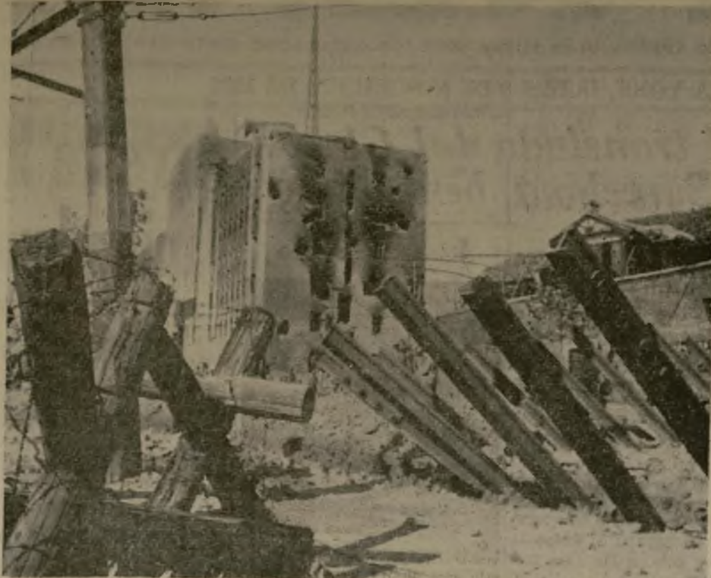
Una "trampa para tanques" hecha de rieles de ferrocarril enterrados que apuntan hacia las posiciones japonesas, la cual los chinos han encontrado más efectiva para detener los avances que las zanjas hondas abiertas, en los caminos.
