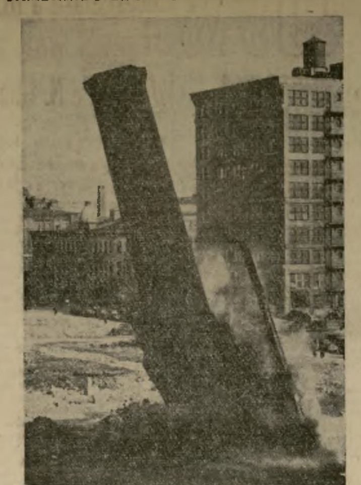
Una chimenea de ladrillo, de 125 pies de altura, se parte en dos al empezar a verse al suelo tirada por cables amarrados a un potente tractor. Fué derrumbada con el fin de despejar el sitio para nuevos edificios que serán construidos en el lugar de la antigua planta de las locomotoras Baldwin.
