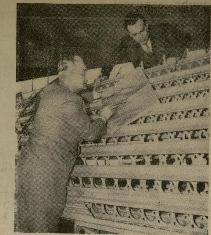
A. S. Barclay (izquierda) de Detroit, inventor, y Lee Gehlbach, piloto probador, examinando una de las nuevas alas celulares esportadas en frecuentes puntos de la cuerda por miembros de todo el largo de la envergadura, las cuales serán probadas próximamente para ser adoptadas por los aviones navales de los Estados Unidos.
