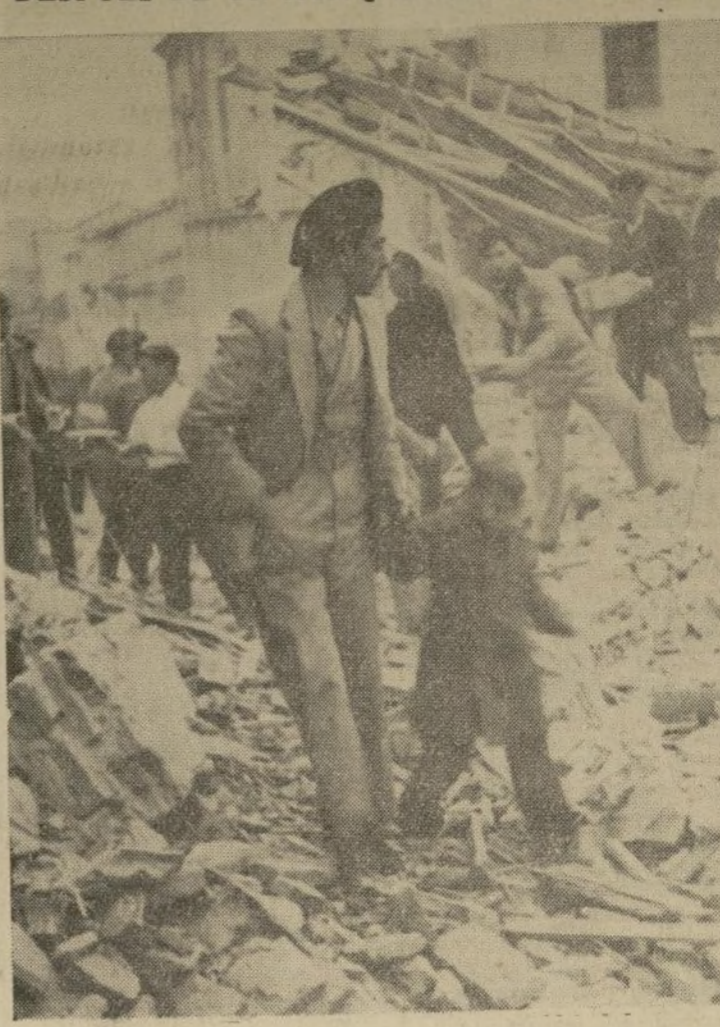
Obreros registran las ruinas de una casa, destruida por una bomba arrojada por un avión rebelde sobre la capital, buscando los cadáveres de las personas atrapadas en el edificio.
