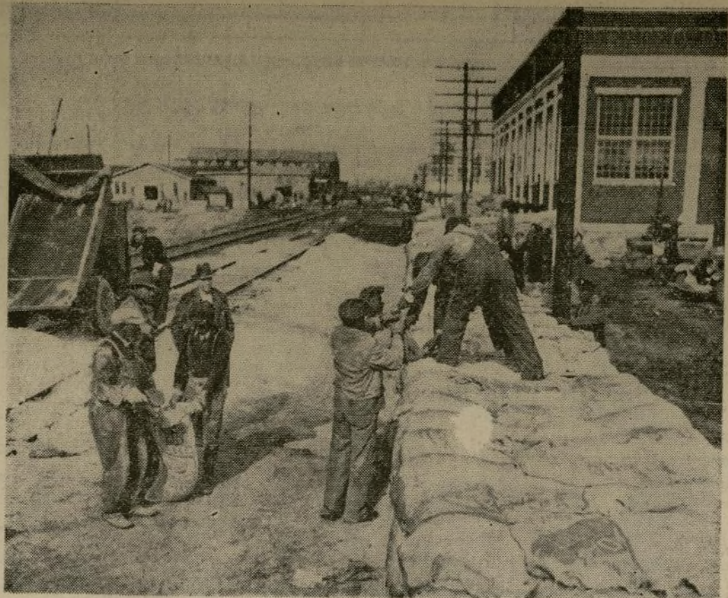
Trabajadores voluntarios haciendo una muralla de sacos de arena para formar un dique de emergencia cerca de la ribera del Mississippi en Memphis, Tenn. Este pueblo, como muchos otros, se prepara para cuando el agua llegue a su punto más alto lo cual, según predicciones de meteorólogos, será de 3 pies más alto que los records establecidos en previas inundaciones.
