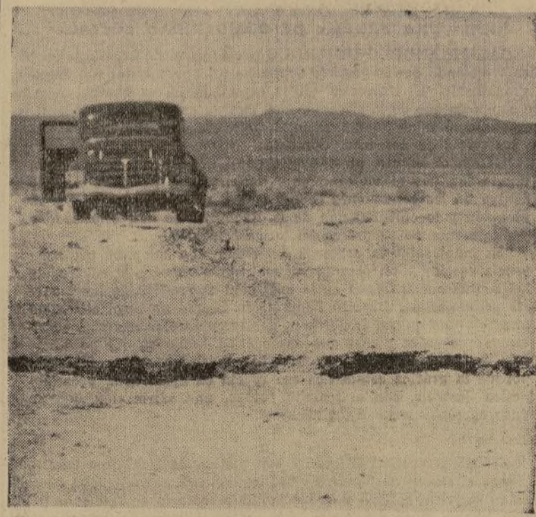
Grieta que se abrió en una carretera después de un movimiento sísmico que se sintió en cinco Estados del Oeste, aunque los daños han sido de poca consideración.
