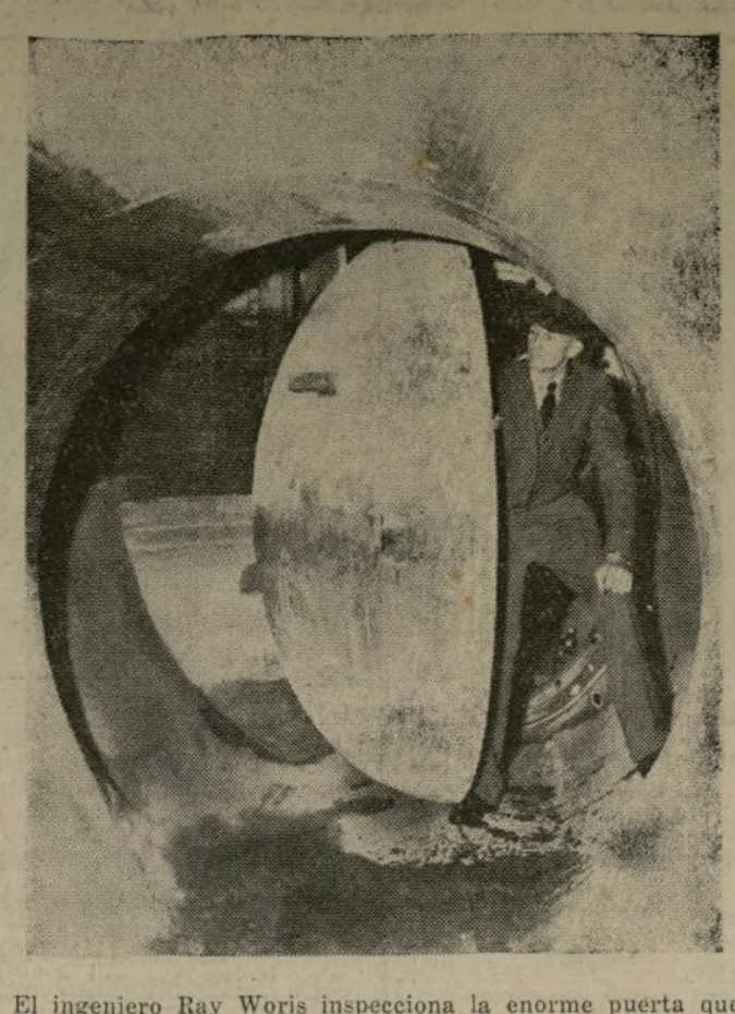
El ingeniero Ray Woris inspecciona la enorme puerta que da acceso a la entrada del viaducto de 20 millas de largo que llevará agua a Brooklyn desde los grandes depósitos de abastecimiento situados en Yonkers, N. Y. El túnel corre a 500 pies bajo el suelo.
