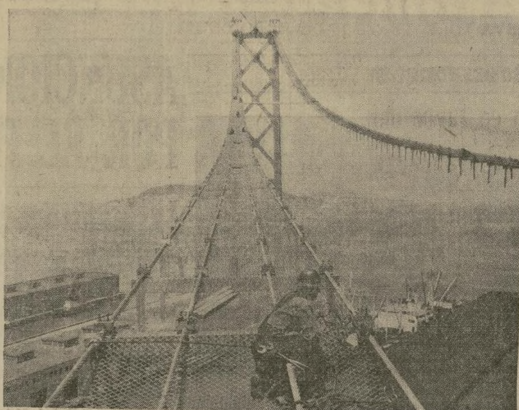
Trabajadores colocando rejilla de alambre en una de las pasarelas que se extienden desde la torre de San Francisco a la de Yerba Buena. Los cables que han de soportar el puente serán tendidos a tres pies de altura de la pasarela.
