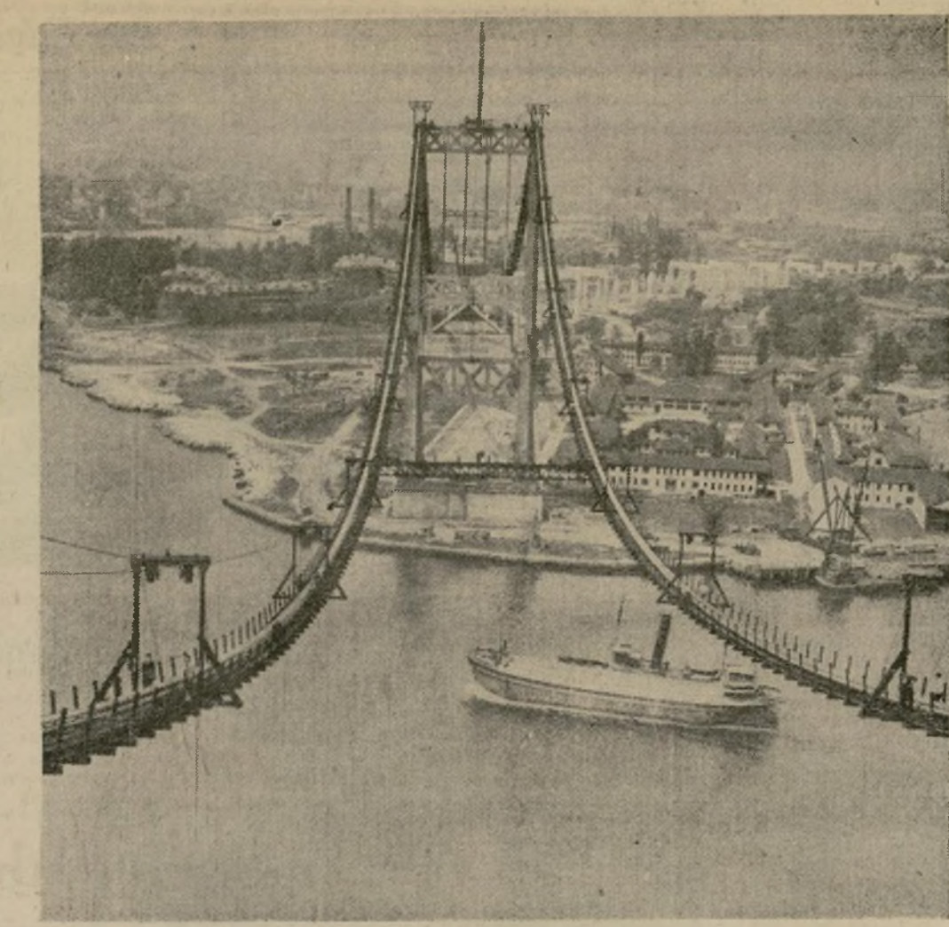
Pasarelas entre las torres del nuevo puente a través de Hell Gate, una de las unidades del puente triple que unirá los distritos de Queens, Manhattan y Bronx.
