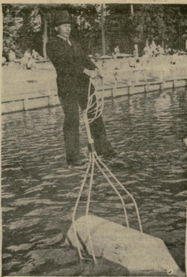
Reinhold Rucker, cerrajero de Leipzig, Alemania, demuestra un aparato de su construcción consistente en un asiento montado por medio de una armazón de acero sobre un pontón. Un peso y dos aletas estabilizadoras colocadas en el estabilizador debajo del agua mantienen el aparato en equilibrio vertical.
