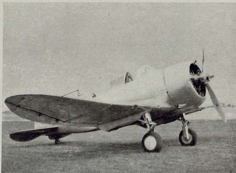
Avión Seversky "Fighter" con tren de aterrizaje plegable de nuevo tipo. Este avión se clasificó como más rápido en las carreras de Cleveland
