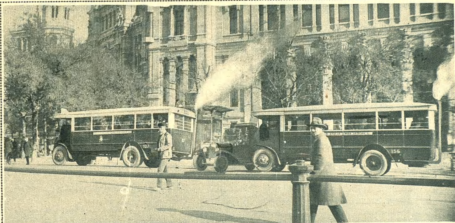
Adaptación del escape vertical á los grandes coches actuales, evitando que los gases invadan la capa atmosférica más baja, que es la respirable
