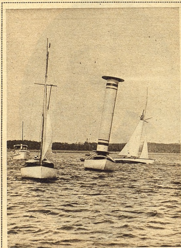
El barco sin velas del doctor alemán Antón Flettner, visto de cerca, navegando á toda marcha en competencia con dos canoas automóviles, á las cuales alcanza sin gran dificultad
