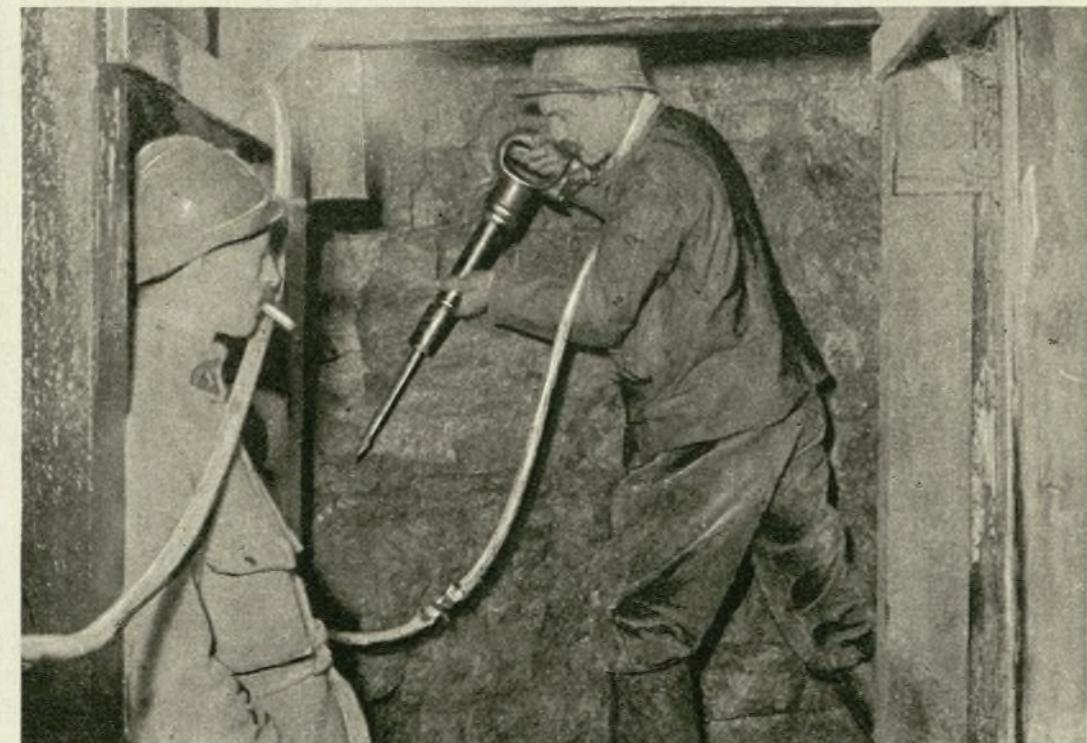
Travaux de forage de sape à l'aide de marteau pneumatique. — Boring a sap by means of a pneumatic hammer. — Lavori di scavamento di zappa col martello pneumatico. — Trabalhos de sape, por meio do martelo pneumático. — Trabajos de zapa y mina por medio del martillo pneumático.
