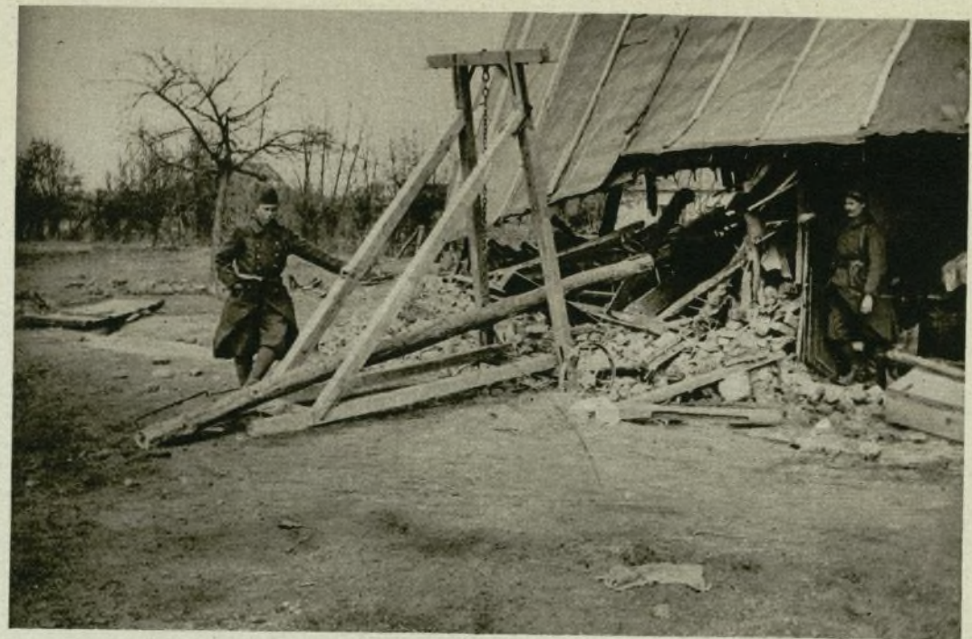
Margny-aux-Cerises: béliet pour démolir les maisons. — Margny-aux-Cerises: battering-ram for the destruction of buildings. — Margny-aux-Cerises: ariete per demolire le case. — Margny-aux-Cerises: machina para demolir as casas. — Margny-aux-Cerises: máquina para demolir casas. — Margny-aux-Cerises: Sturmbock zum Abbruch der Häuser.
