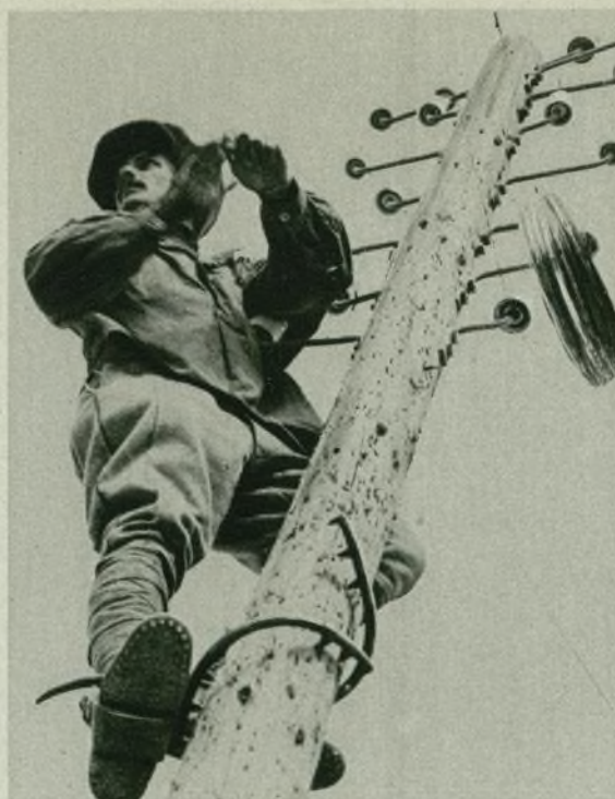
b. — Réparation des lignes téléphoniques — Repairing the telephone lines. — Riparazione di linee telefoniche. Reparação das linhas telefônicas. — Reparación de líneas telefónicas. — Ausbesserung der Fernsprech- Verbindungen.
