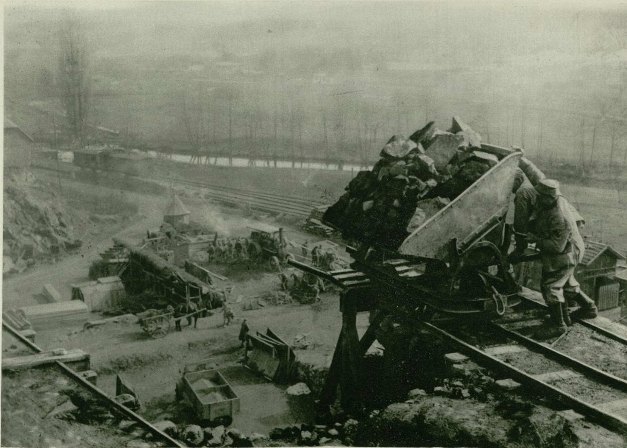
L'extraction de la pierre. — Taking the stones from the quarry. — L'estrazione della pietra. — A extracção da pedra. — La extracción de piedra. — Gewinnung des Gesteins.
