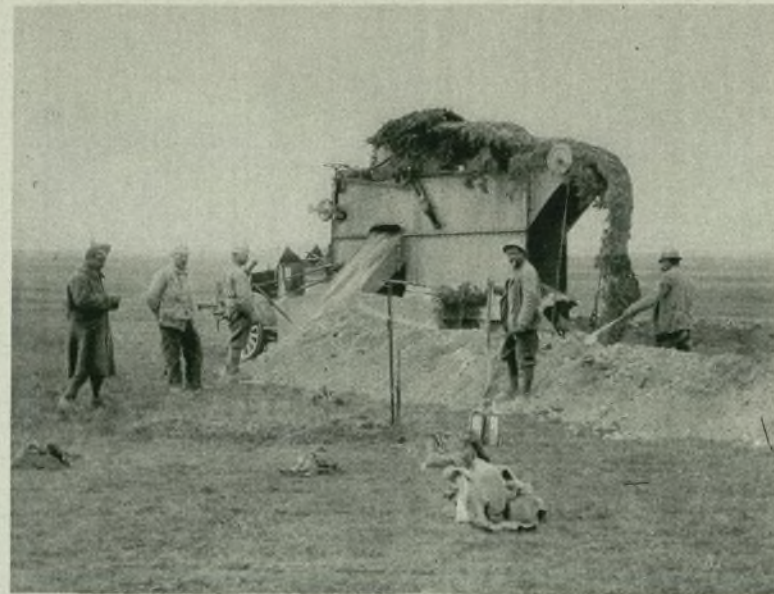
c. — Machine à creuser les tranchées. — Trench-digging machine. Scavatrice di trincee. — Machina para cavar as trincheiras. — Má- quina para cavar trincheras. — Baggermaschine für Schützengräben.
