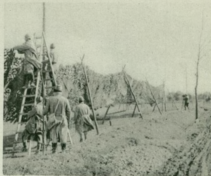
Route camouflée à l'aide de branchages. — Road disguised with greenery. — Strada camuffata con frasche. — Estrada dissimulada por meio de ramagens. — Camino desfigurado con ramas de árboles cortadas. — Eine mit Astwerk abgedeckte Strasse.
