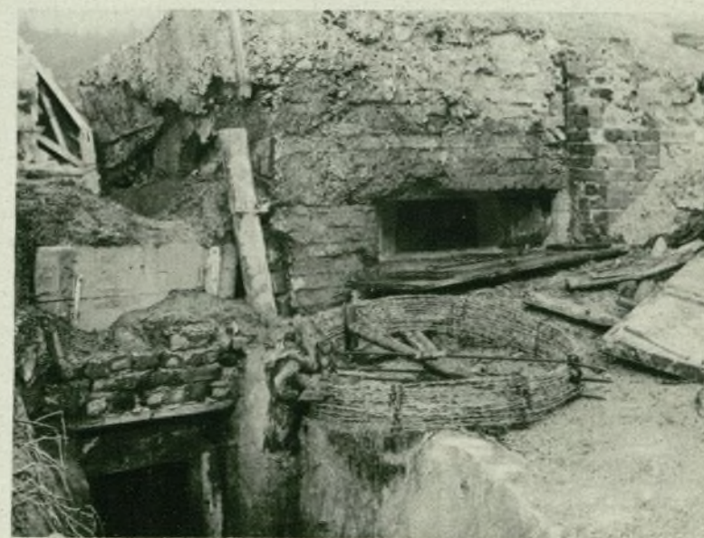
Une casemate bétonnée de mitrailleuse. — A cemented casemate for machine-guns. — Una casamatta cementata da mitragliatrice. — Uma casamata, cimentada, de metralhadoras. — Una casamata revestida de cemento para ametralladora. — Betonniertes Unterbau für Maschinengewehre.
