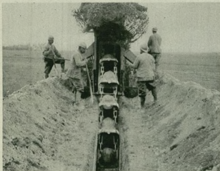
a. — Machine à creuser les tranchées. — Trench-digging machine. Scavatrice di trincee. — Machina para cavar as trincheiras. — Má- quina para cavar trincheras. — Baggermaschine für Schützengräben.
