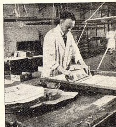
Las hojas impresas se cuelgan o se colocan en bastidores, para que se sequen antes de aplicar el segundo color.
