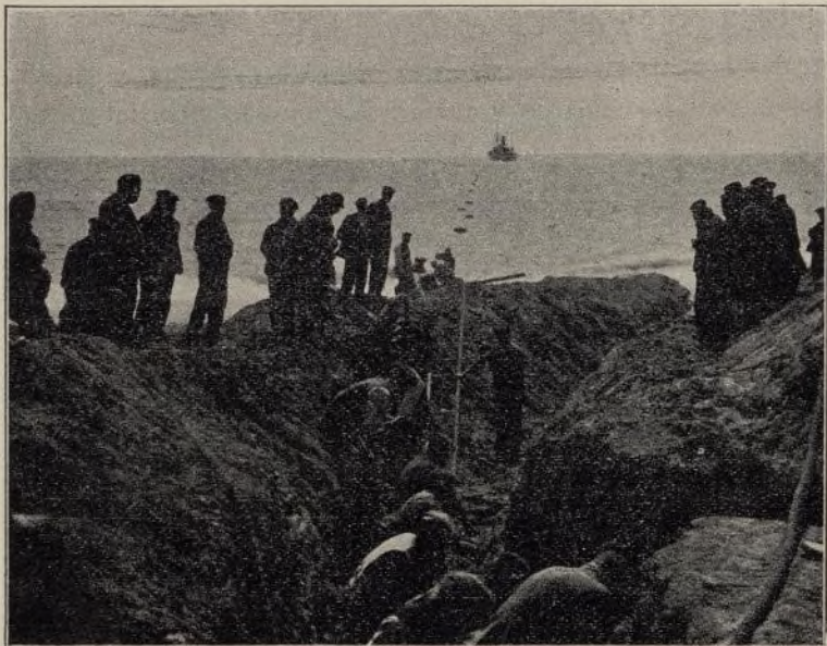
BARCELONA.—Tendido del cable submarino que comunica con Palma de Mallorca
