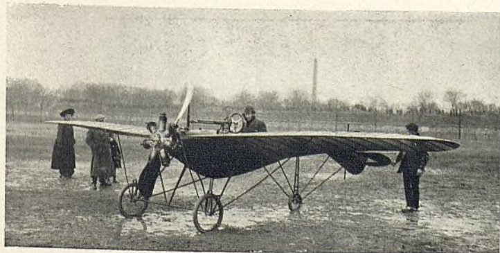
Monoplano «John Moisant». — Motor Gnome de 7 cilindros, 50 HP.
