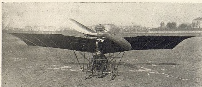
Monoplano «Demoiselle» de Clément-Bayard, tipo Santos Dumont, con motor Clément 2 cilindros 30 HP., pilotado por M. Mauricio Clément
