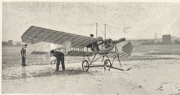
El monoplano del Principe Nissolle. Superficie, 16 m 2 ; envergadura, 9 m.; longitud, 9 m.; peso 320 kg.; motor Anzani de 25 HP. Es el único monoplano que lleva timón de profundidad delantero.
