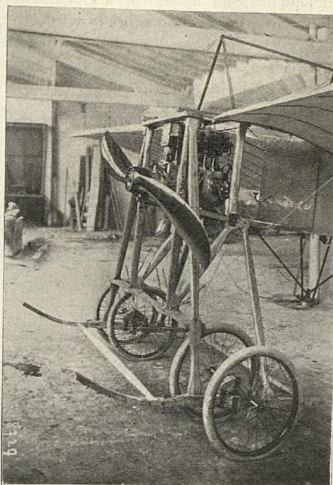
Vista del chasis delantero y juego de aterrisaje del nuevo aparato Grapperon
