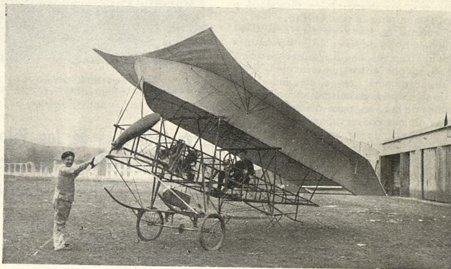
L'Aérien, de M. M. Gonnell, forma de buque y de paracaídas, especial para el vuelo planeado Vista de conjunto
