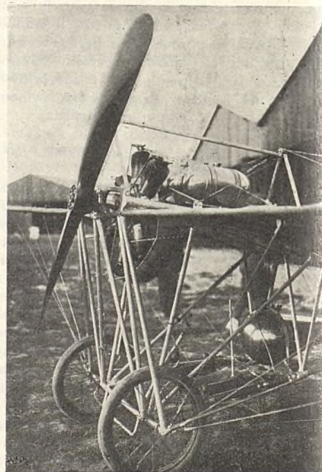
Detalles del emplazamiento del motor y chasis de aterrisaje del monoplano Bébé-Moisant
