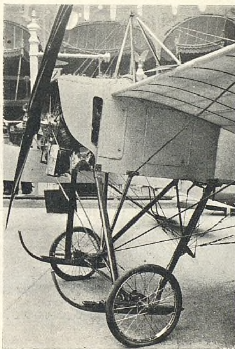
Tercera Exposición internacional de Locomoción aérea Detalles del aparato de aterrizaje del monoplano Morane
