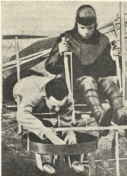
Fig. 4. Primeros ensayos del sistema lanzabombas Scott en América. — El teniente Scott colocando el aparato de su sistema, en un biplano militar pilotado por el teniente americano Milling
