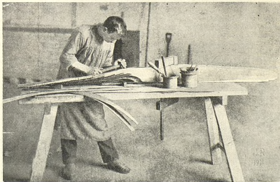
Fig. 4. Aplicando chapas a las palas
