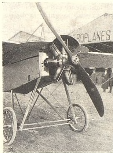
Chasis de aterrizaje y parte delantera del nuevo monoplano Sommer
