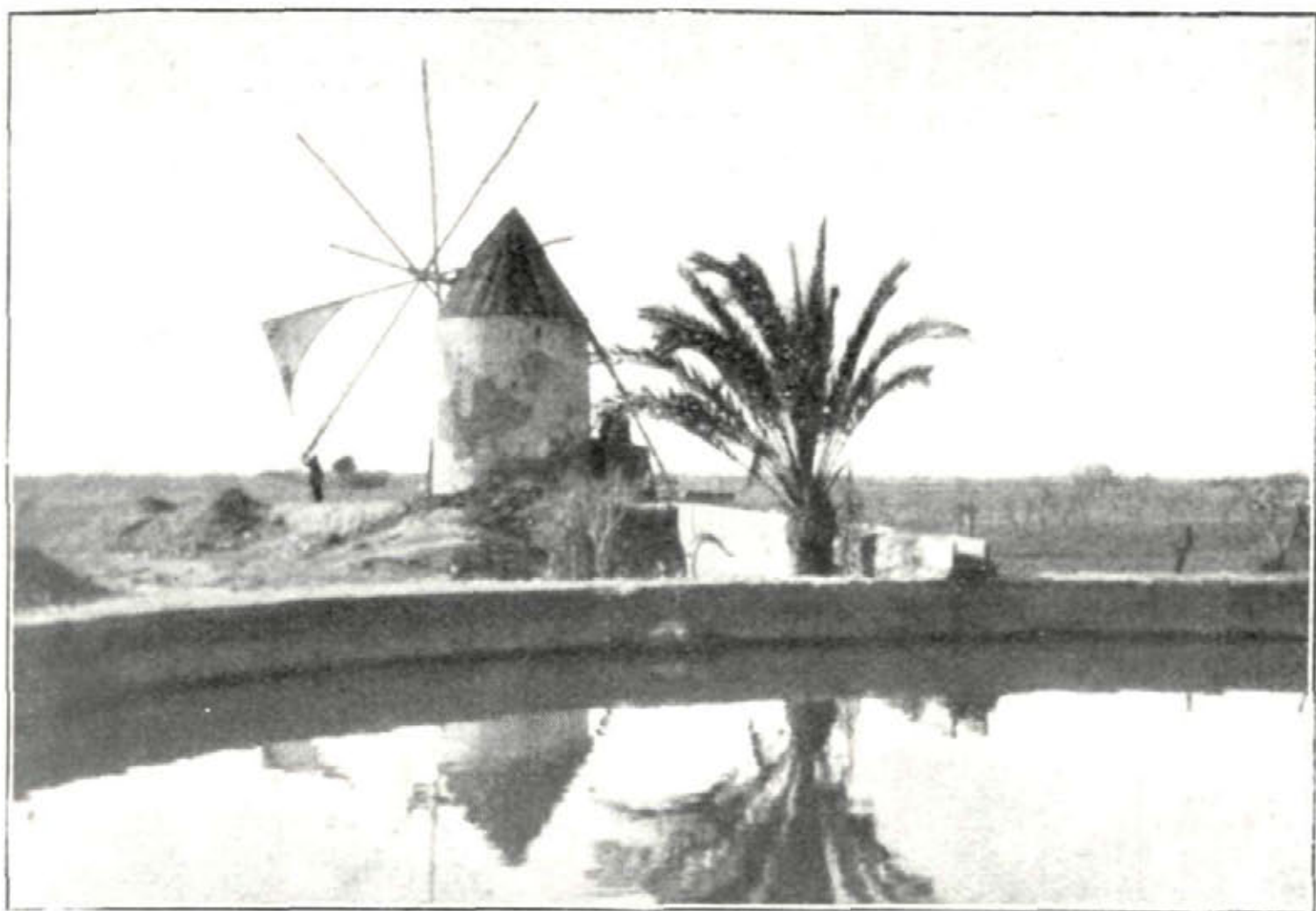
Este molino del campo de Cartagena—uno de los numerosos que existen en funcionamiento—es insustituible, por su económico gasto, para sacar agua de riego alimentando la balsa en la que refleja su airosa silueta.
