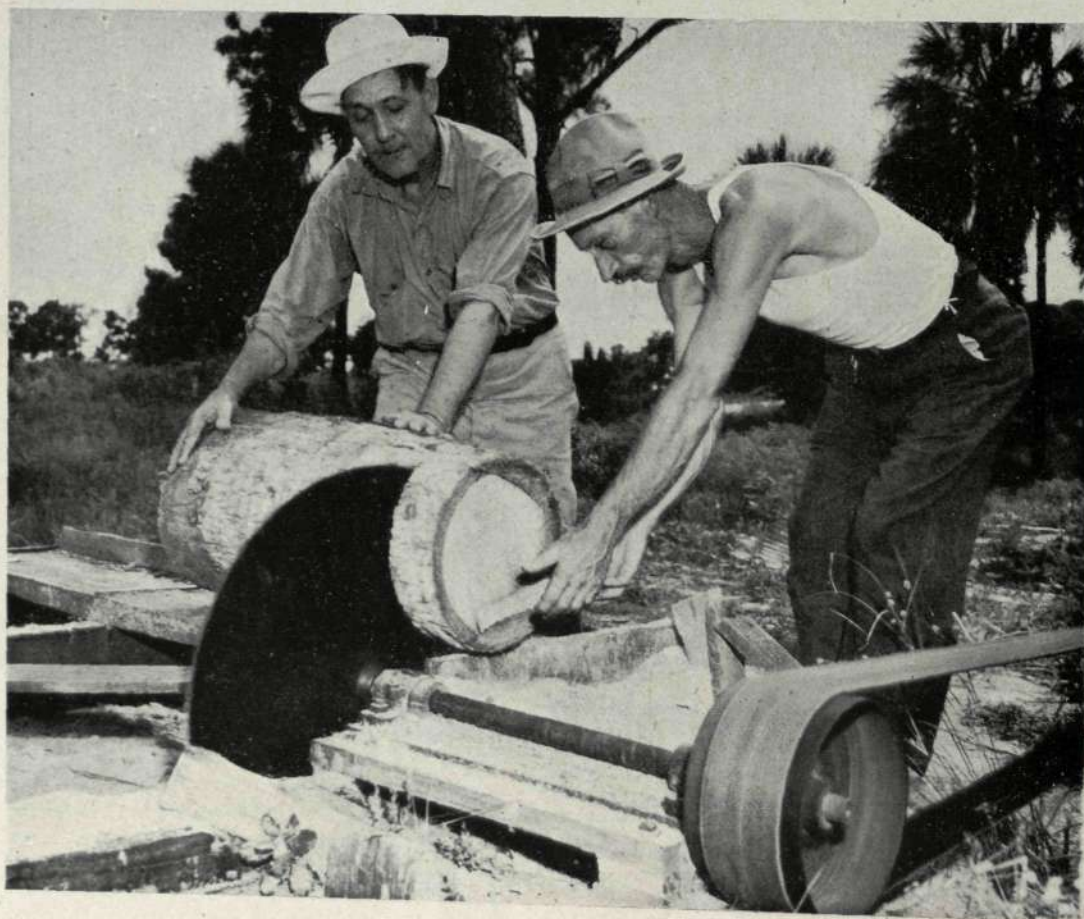
Baker y un amigo que le ayuda cortan el tronco en la sierra mecánica.
