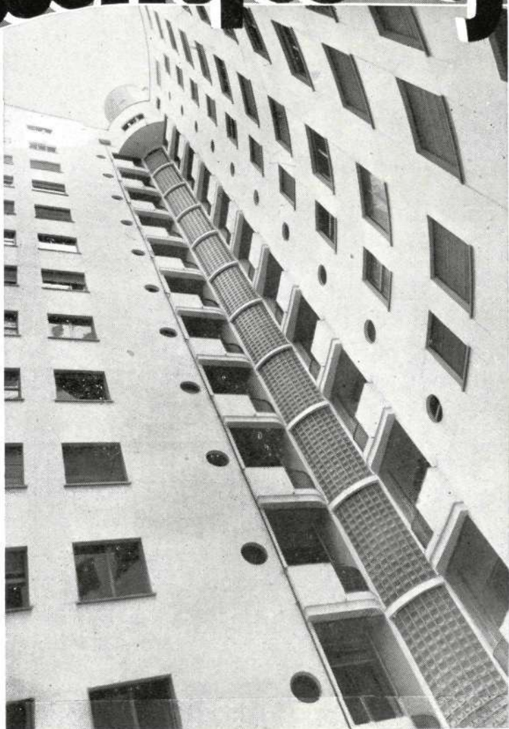
Instalación de Baldosas Nevadas en caja de ascensor del rascacielos de la plaza de Urquinaona, Barcelona (14 pisos)
